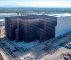
MAXIMUM CONSTRUCTION HEIGHT: CLAD-RACK WAREHOUSES CAN BE BUILT FROM AS LITTLE AS 12 M UP TO 45 M HIGH.
